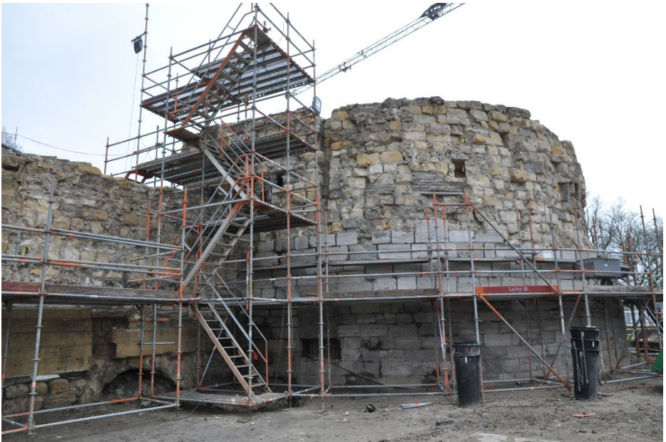
De buitenzijde van de stadsmuur en het rondeel, tijdens de restauratie van de natuurstenen buitenschil.
