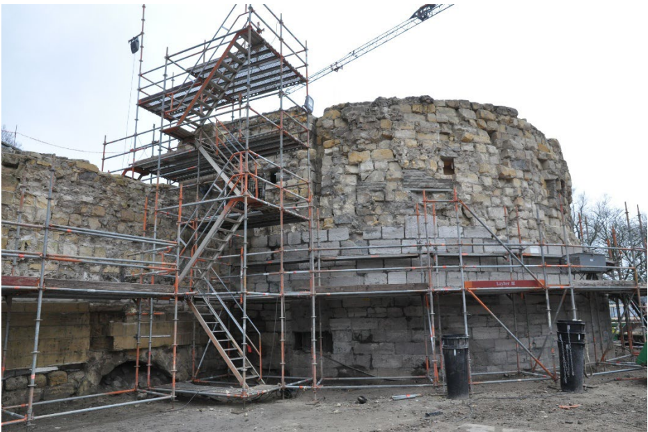
De buitenzijde van de stadsmuur en het rondeel, tijdens de restauratie van de natuurstenen buitenschil (Buro4 Bouwhistorie).
